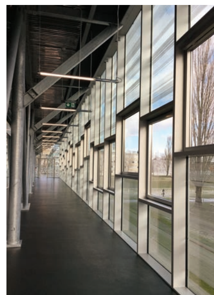
La coursive intérieure de l'étage.
