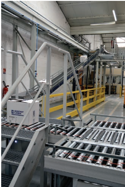
Embranchement avec la mezzanine .
