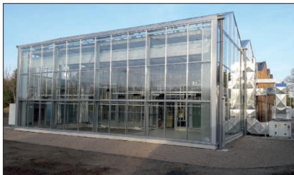
grands formats de verre associés aux profilés en aluminium à rupture de pont thermique Ecoklima (exclusivité de CMF). Ces verres en double vitrage ont un coefficient d'isolation thermique  $U_w$  de 1,5 W/m<sup>2</sup>.K.
