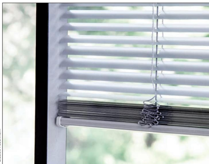
Vitrage avec stores intégrés ISO-Shadow avec Swisspacer Ultimate 32 mm
