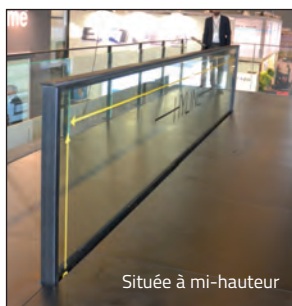
La fenêtre levante par coulissement vertical, entièrement relevée
