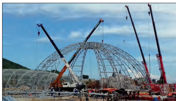
Le ballet des grues pour le levage d'une structure
