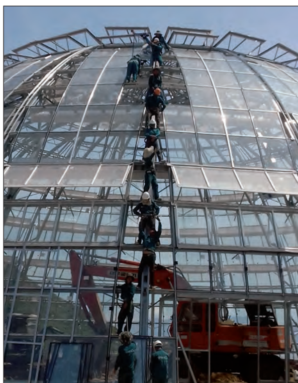
Le montage des petits verres au raccordement entre deux portions de dôme.
