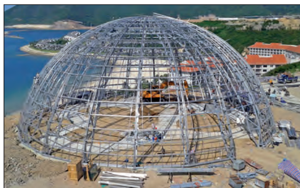
Une structure terminée.
