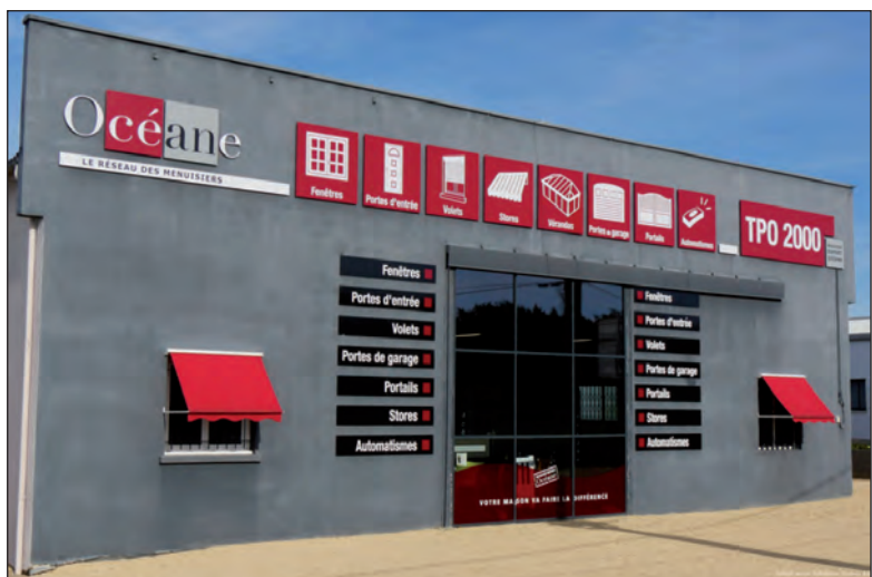
La façade de TPO 2000
