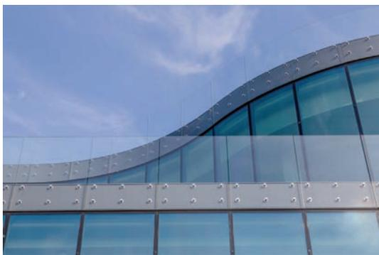
grer des garde-corps en façade sur un calepinage de 1,5 m par 4,11 m pour un poids jusqu'à 500 kg.
