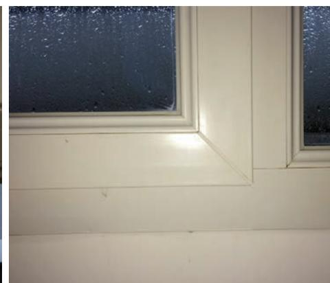
**Voici le risque que court le PVC non-renforcé** appliqué à des dimensions de fenêtres importantes : affaissement des profilés d'ouvrant au point de ne plus assurer l'étanchéité à l'air, ni même la fermeture de la fenêtre.
