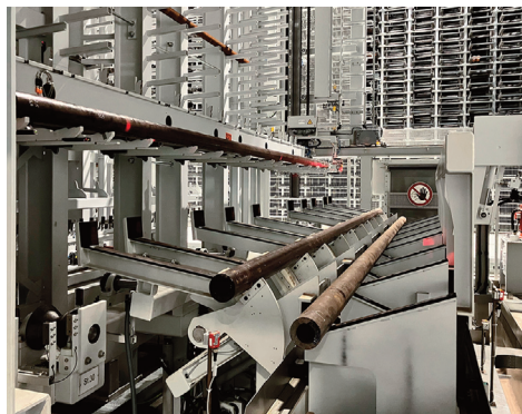
Le système démagnétise et sépare 15 tonnes de produits longs en acier. Il transporte les tubes et les barres (trois ou six mètres de long et de diamètre 22 à 260 mm) vers la scie, qui les découpe et les prépare pour la fabrication.
