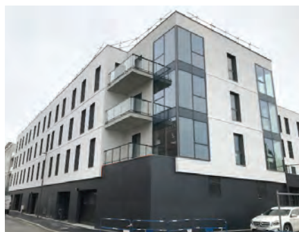
Façade rue de l'amiral Nielly
