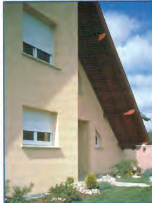
construit une nouvelle usine à Froideconche, dans la Haute-Saône, consacrée exclusive-
