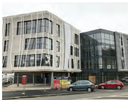
Proue et façade rue Jean-Marie Le Bris en cours de chantier
