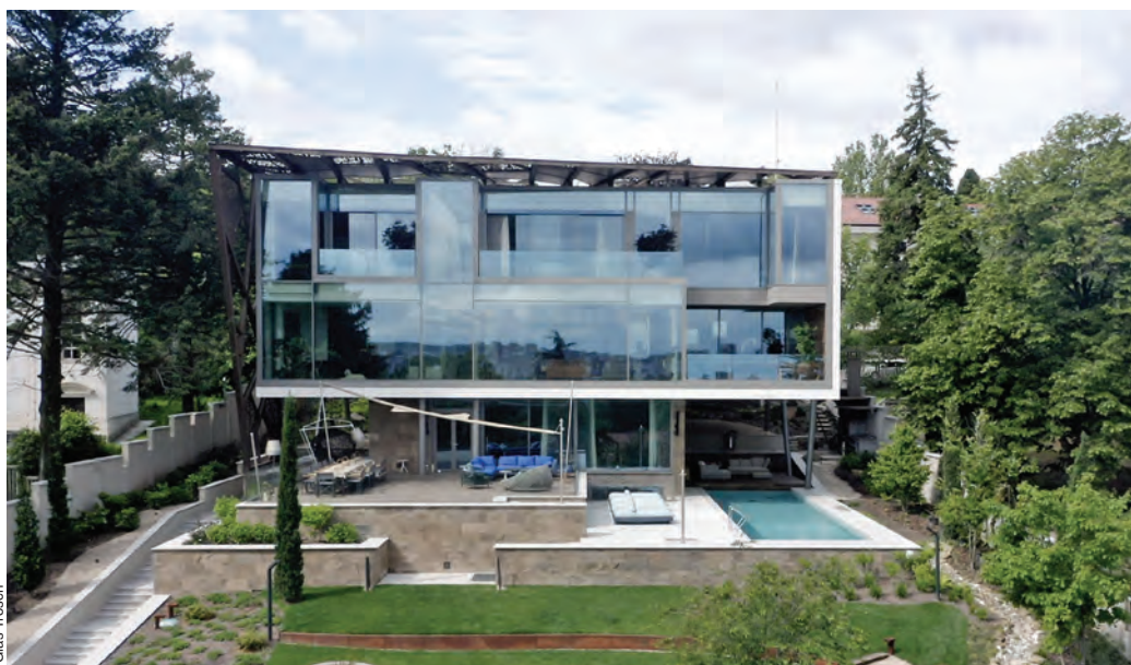
Les architectes, vu la complexité du terrain très en pente, ont choisi d'adosser la villa contre le versant de la colline dans le sens de la longueur pour pouvoir ouvrir du côté nord-est une superbe façade vitrée en relief.
