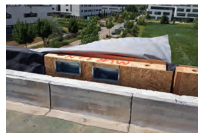
La tête du panneau le long de l'acrotère de la terrasse, avant son recouvrement pour la protéger.
