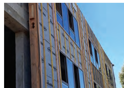
Panneau équipé en cours de pose.
