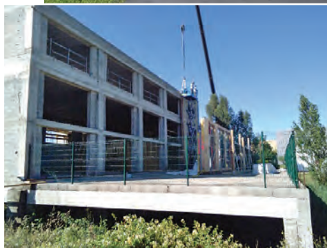
Poses d'une paroi latérale et d'une paroi de 12 m de haut.
